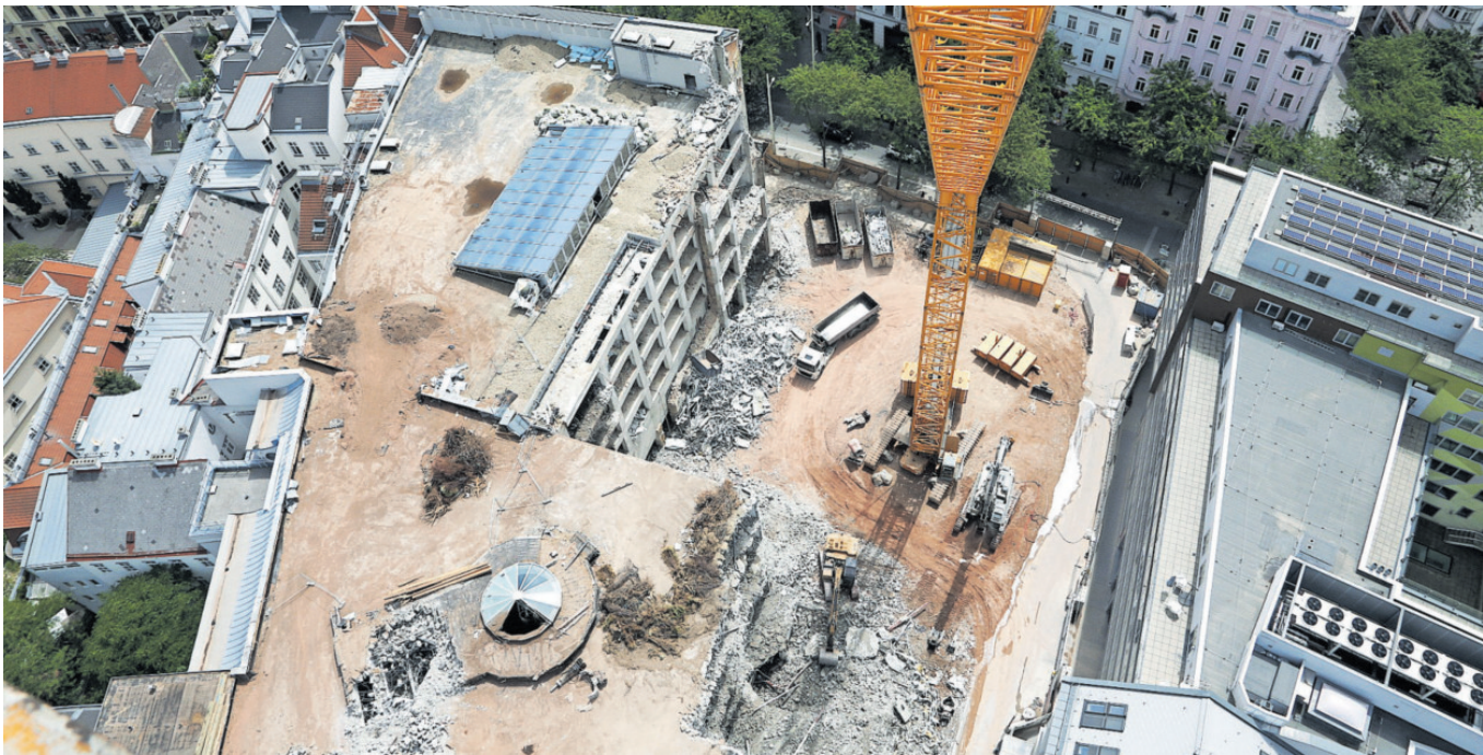
Bauarbeiten in dicht besiedelten Gebieten erfordern eine besonders ausgefeilte Logistik. Im Bild die Baustelle für das neue Wiener KaDeWe in der Mariahilfer Straße.
